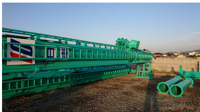
荷張りピース取付
