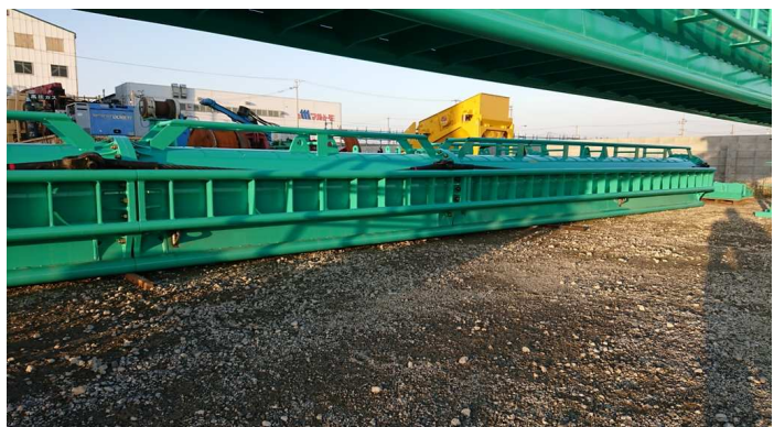
荷張りピース取付
