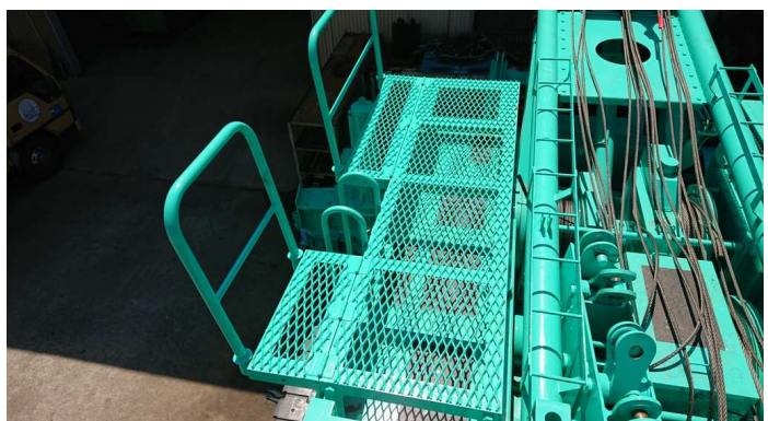
右配電盤架台 700×2650
